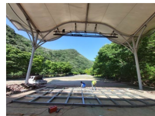
하지프레임 설치 완료
