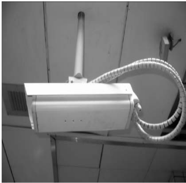
(그림 V-18) 지하철 역사내 CCTV 설치사진
