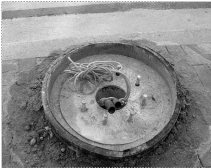
(그림 V-15) CCTV 기초대 설치사진
