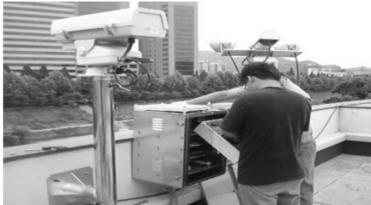
(그림 V-20) 하천 수위감시 CCTV 설치사진
