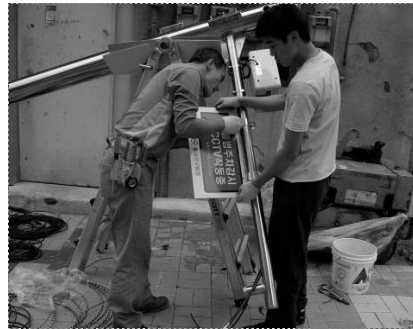
(그림 V-15) CCTV 기초대 설치사진
