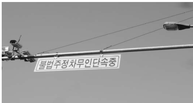
(그림 V-24) 불법주정차 무인단속 카메라 설치사진
