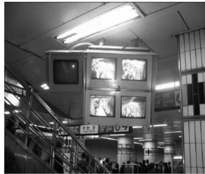
(그림 V-18) 지하철 역사내 CCTV 설치사진
