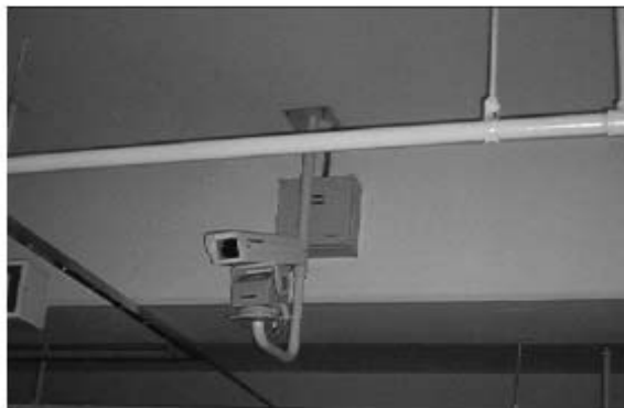
(그림 V-14) 지하주차장내 CCTV 설치사진
