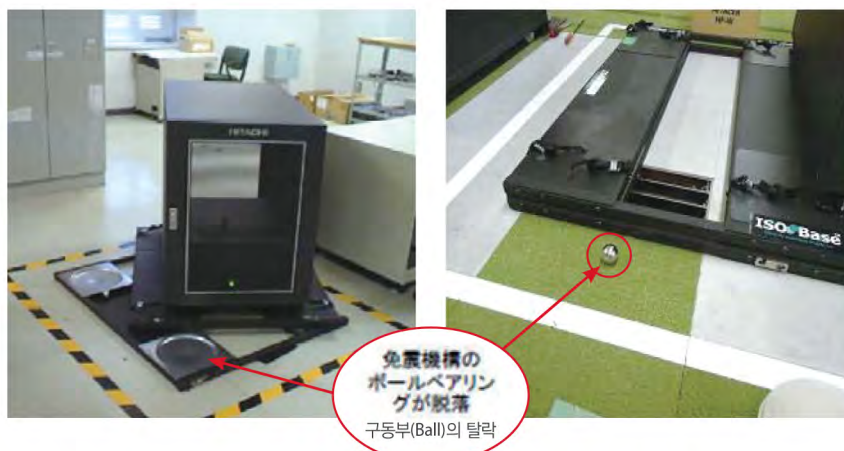
写真 3-8-2 <参考> 茨城支店等で機器免震装置の被災状況
